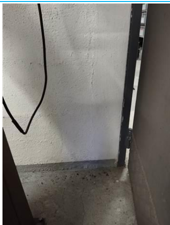
Matériaux : Z05 - Pièce 13, Pièce 14, Pièce 11 - Mur - enduit + peinture Prélèvement : P011 Description : enduit + peinture Localisation : RDC - Pièce 13 - Mur Résultat : Absence d'amiante
