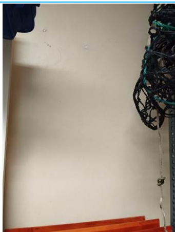
Matériaux : Z05 - Pièce 13, Pièce 14, Pièce 11 - Mur - enduit + peinture Prélèvement : P013 Description : enduit + peinture Localisation : RDC - Pièce 11 - Mur Résultat : Absence d'amiante
