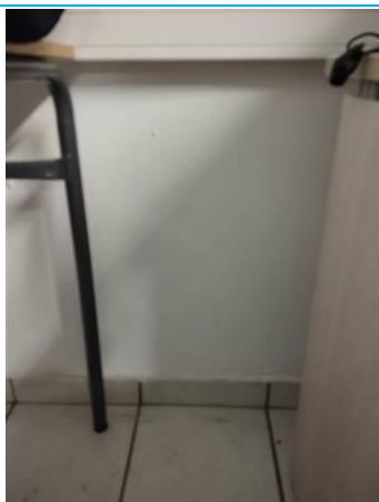
Matériaux : Z01 - Bureau - Mur - enduit + peinture Prélèvement : P003 Description : enduit + peinture Localisation : R+1 - Bureau - Mur Résultat : Absence d'amiante
