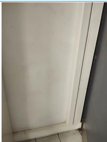
Matériaux : Z01 - Bureau - Mur - enduit + peinture Prélèvement : P001 Description : enduit + peinture Localisation : R+1 - Bureau - Mur Résultat : Absence d'amiante
