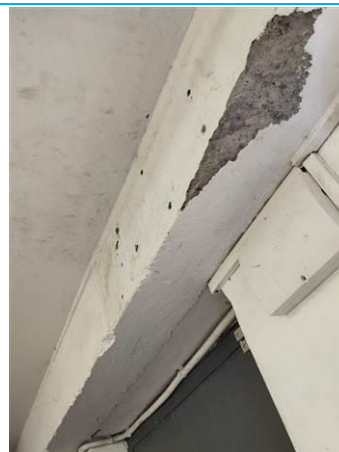
Matériaux : Z03 - Pièce 13, Pièce 14, Pièce 11 - Poutre - enduit + peinture Prélèvement : P006 Description : enduit + peinture Localisation : RDC - Pièce 13 - Poutre Résultat : Absence d'amiante
