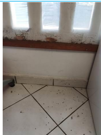
Matériaux : Z01 - Bureau - Mur - enduit + peinture Prélèvement : P002 Description : enduit + peinture Localisation : R+1 - Bureau - Mur Résultat : Absence d'amiante
