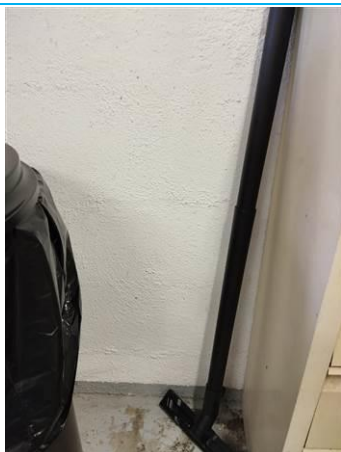
Matériaux : Z05 - Pièce 13, Pièce 14, Pièce 11 - Mur - enduit + peinture Prélèvement : P009 Description : enduit + peinture Localisation : RDC - Pièce 13 - Mur Résultat : Absence d'amiante
