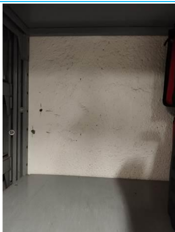
Matériaux : Z05 - Pièce 13, Pièce 14, Pièce 11 - Mur - enduit + peinture Prélèvement : P015 Description : enduit + peinture Localisation : RDC - Pièce 14 - Mur Résultat : Absence d'amiante
