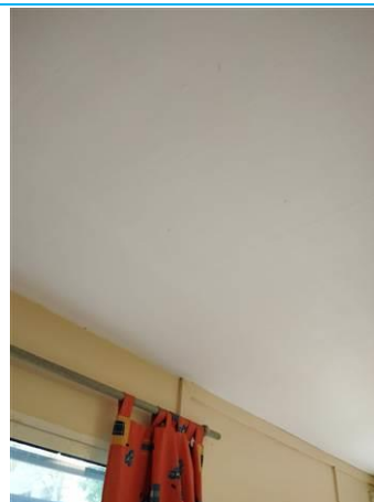
Matériaux : Z04 - Pièce 13, Pièce 14, Pièce 11 - Plafond - enduit + peinture Prélèvement : P022 Description : enduit + peinture Localisation : RDC - Pièce 11 - Plafond Résultat : Absence d'amiante
