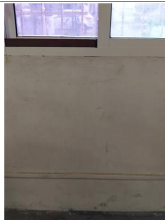
Matériaux : Z05 - Pièce 13, Pièce 14, Pièce 11 - Mur - enduit + peinture Prélèvement : P008 Description : enduit + peinture Localisation : RDC - Pièce 13 - Mur Résultat : Absence d'amiante
