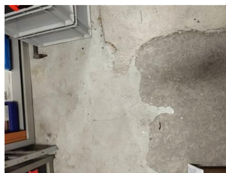
Matériaux : Z06 - Pièce 14, Pièce 13 - Sol - chappe + peinture Prélèvement : P016 Description : chappe + peinture Localisation : RDC - Pièce 14 - Sol Résultat : Absence d'amiante
