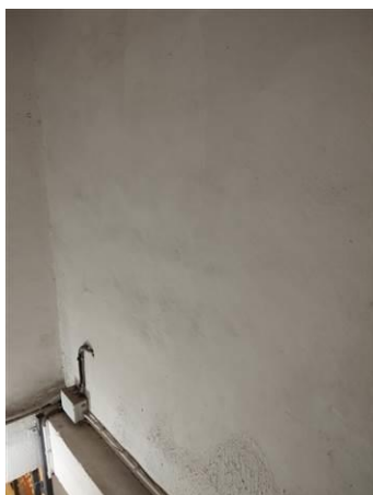
Matériaux : Z02 - Cage d'escalier - Mur - enduit + peinture Prélèvement : P005 Description : enduit + peinture Localisation : R+1 - Cage d'escalier - Mur Résultat : Absence d'amiante
