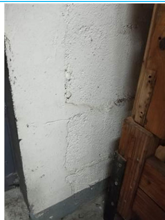
Matériaux : Z05 - Pièce 13, Pièce 14, Pièce 11 - Mur - enduit + peinture Prélèvement : P012 Description : enduit + peinture Localisation : RDC - Pièce 14 - Mur Résultat : Absence d'amiante
