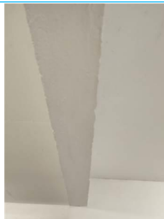
Matériaux : Z03 - Pièce 13, Pièce 14, Pièce 11 - Poutre - enduit + peinture Prélèvement : P010 Description : enduit + peinture Localisation : RDC - Pièce 13 - Poutre Résultat : Absence d'amiante
