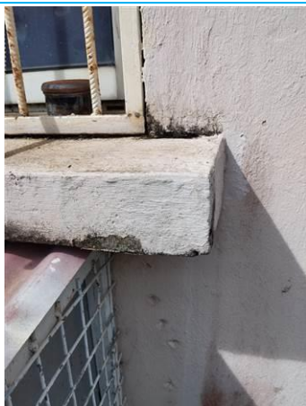
Matériaux : Z10 - Façades extérieures NE et NO - Appuie fenêtre - enduit + peinture Prélèvement : P023 Description : enduit + peinture Localisation : Parties extérieures - Appuie fenêtre Résultat : Absence d'amiante
