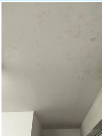
Matériaux : Z04 - Pièce 13, Pièce 14, Pièce 11 - Plafond - enduit + peinture Prélèvement : P007 Description : enduit + peinture Localisation : RDC - Pièce 13 - Plafond Résultat : Absence d'amiante
