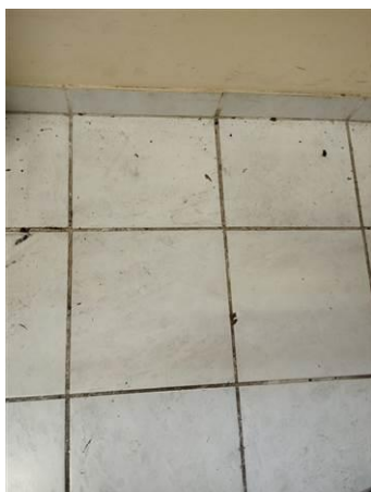
Matériaux : Z09 - Pièce 11 - Sol 30x30 - colle de carreau Prélèvement : P021 Description : enduit + peinture Localisation : RDC - Pièce 11 - Sol Résultat : Absence d'amiante
