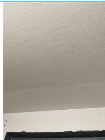
Matériaux : Z04 - Pièce 13, Pièce 14, Pièce 11 - Plafond - enduit + peinture Prélèvement : P014 Description : enduit + peinture Localisation : RDC - Pièce 14 - Plafond Résultat : Absence d'amiante
